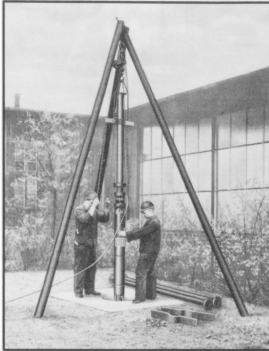
شکل ۱۷- روش نصب الکتروپمپ شناور
